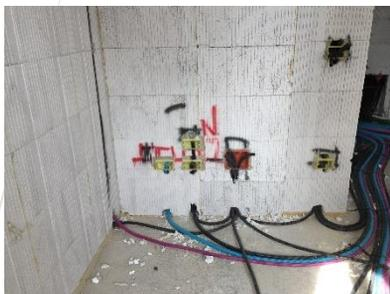
**La realizzazione degli impianti** è uno dei punti di forza del divisorio Carbon, basterà infatti utilizzare un coltello a lama calda per realizzare impianti in modo rapido e preciso, senza generare macerie e polvere. Le cavità all'interno dell'elemento divisorio poi, permettono di tenere «nascosti» i corrugati o le tubazioni senza dover scavare l'intera traccia muraria.
