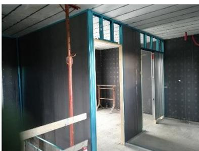
**Il Fissaggio delle controcasse**, normali o scorrevoli, avverrà con i medesimi principi dei tramezzi a secco tipo cartongesso. Si ancoreranno le stesse ai montanti affogati all'interno dei pannelli Carbon, e si fisseranno sulle guide metalliche superiore ed inferiore per rendere il tutto solidale agli impalcati.
