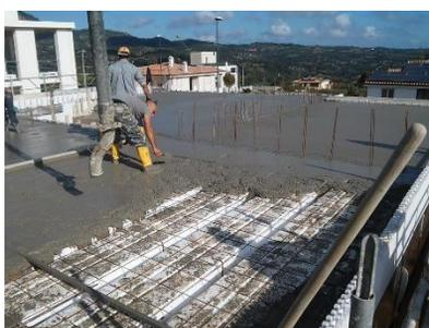
**Iniziare il getto del calcestruzzo** facendo sì che vada a depositarsi sulla superficie della pignatta e «cada» nell'alloggio del travetto. Evitare il getto diretto nella gola del travetto per evitare possibili rotture del polistirene dell'aletta sottotravetto. Vibrare e bagnare come da specifiche della direzione lavori. A maturazione del getto disarmare come sui sistemi tradizionali.
