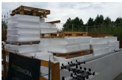
**In Solaio in KIT di montaggio** arriverà disassemblato in cantiere. Questo renderà il trasporto molto più efficiente in quanto il solaio arriverà compattato, e permetterà di riempire gli autocarri completamente senza trasportare inutilmente aria. Le pignatte arriveranno in bancali, e i listelli in fascette. Assemblare il tutto in cantiere sarà estremamente semplice. Basterà disporre di un piano complanare (una platea o un solaio) e il gioco è fatto.
