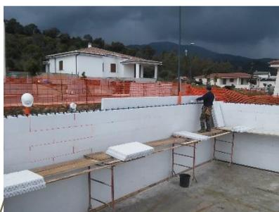
**Posato il ferro della prima fila**, si procede con la seconda, avendo cura di sfalsare i pannelli di circa 50 cm, in modo da non avere continuità verticale delle giunte. Completata la seconda fila, si procede con le successive allo stesso modo, le file dispari saranno come la prima e le pari come la seconda, sino al raggiungimento della quota di progetto.
