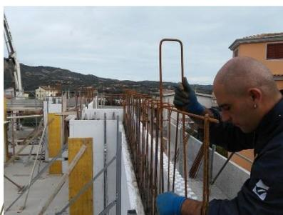
**Ultimato il getto del calcestruzzo,** qualora si debba procedere con un nuovo piano della struttura, si posizioneranno i richiami per collegare e rendere solidali i vari livelli.
