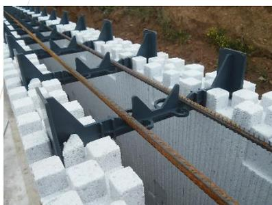
**Completata la posa dei pannelli e dei distanziatori** del primo corso, si procede con la posa del ferro orizzontale negli alloggi previsti nel distanziatore stesso. LA sede ha una particolare forma che scongiura qualsivoglia spostamento delle barre di armatura durante le fasi di getto, anche senza legature, garantendo sempre la corretta posizione delle stesse e il rispetto del copriferro minimo.
