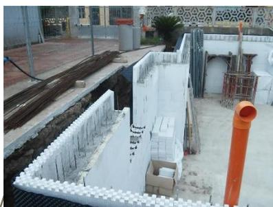
**Arrivati alla quota di progetto**, si taglierà il pannello nel senso longitudinale, formando così il nostro piano d'appoggio del solaio. Sul lato esterno invece si lascerà il pannello intero, così da formare la «sponda» del solaio stesso, evitandoci di dover utilizzare qualsivoglia tipo di carpenteria aggiuntiva.
