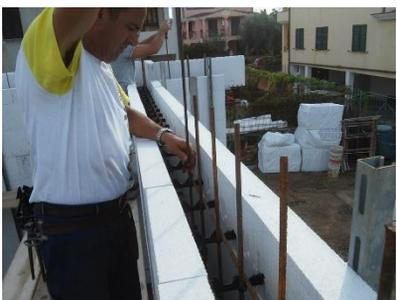
**Non resta altro che infilare i ferri verticali** negli alloggi presenti nei distanziatori. La perfetta concentricità degli anelli, permette di eseguire l'operazione con estrema facilità.
