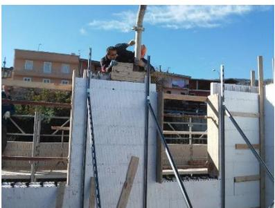
**Ora siamo pronti per il getto** dell'intero piano del fabbricato. Utilizzate un calcestruzzo S4 con granulometria non superiore a 18 mm, disposto in continuità fino a quota solaio ma a corsi di circa 80-100 cm a girare. E' possibile qualora necessario, effettuare una piccola vibratura del calcestruzzo mediante aghi di piccolo diametro, senza soffermarsi insistentemente sulle stesse zone, onde evitare rigonfiamenti o rotture dei pannelli.
