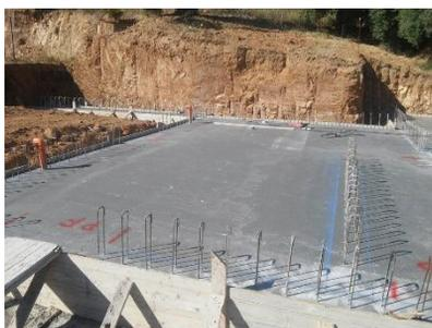
**Tracciare** la linea delle pareti portanti Carbon ED SYSTEM sulla platea o sul solaio da cui dovete partire. Tracciate sempre la muratura al grezzo, cioè al netto delle finiture, così da individuare il preciso punto dove fissare le guide metalliche o le tavole di registro che serviranno come partenza delle vostre pareti. Tracciate anche eventuali forometrie (porte o finestre), questo renderà tutto il lavoro più veloce e semplice.
