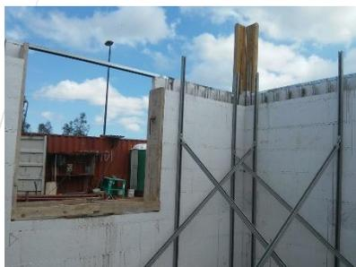
**In corrispondenza delle aperture** si procederà a realizzare le forometrie come da progetto, utilizzando sempre lo stesso pannello muro. Per le specifiche di questa operazione vi rimandiamo agli approfondimenti nelle pagine successive.
