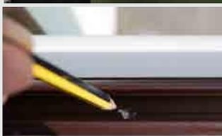
segnare con una matita il punto dove forare con una punta da trapano da Ø 6
