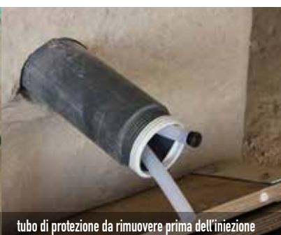
inserimento ancoraggio all'interno del tubo di protezione
