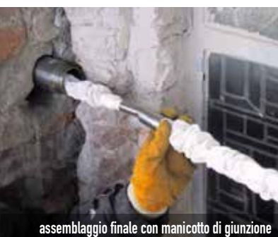
inserimento ancoraggio all'interno del tubo di protezione
