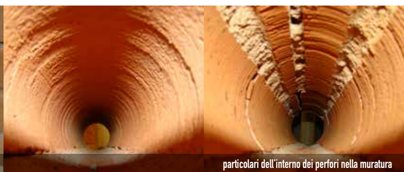
modalità rottura ancoraggi "corti" su banchi prova con malta allettamento tipo A
