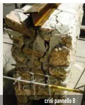
quadro fessurativo pannello B
