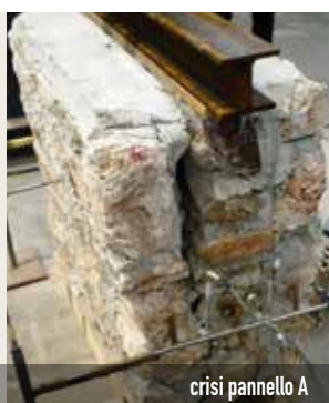
quadro fessurativo pannello A
