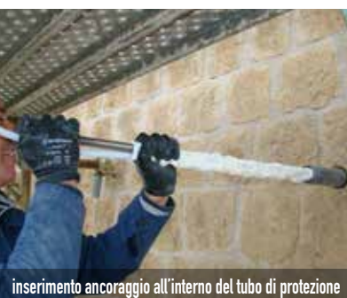
tubo di protezione da rimuovere prima dell'iniezione
