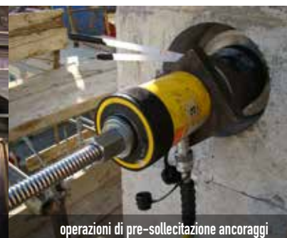
incatenamenti longitudinali esistenti
